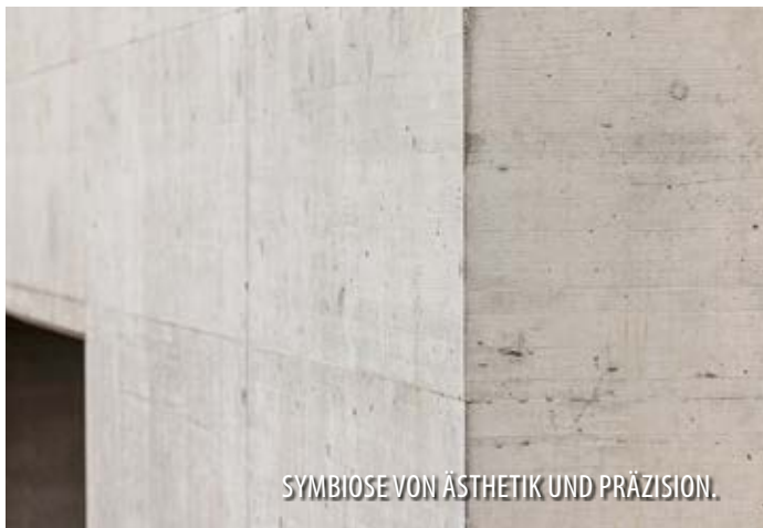
DIE SCHALUNGSBRETTER BEEINFLUSSEN DIE STRUKTUR UND DIE FARBGEBUNG DES SICHTBETONS.
