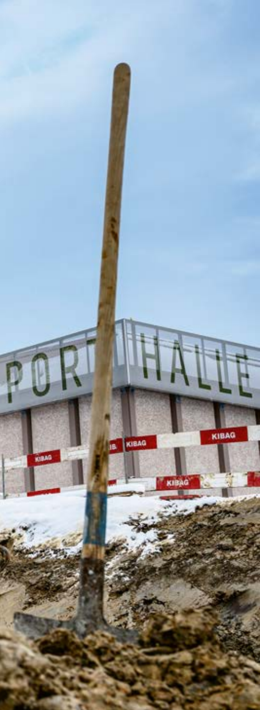
AUSHUBARBEITEN FÜR DEN GRAUWASSERTANKTRIBÜNE.
