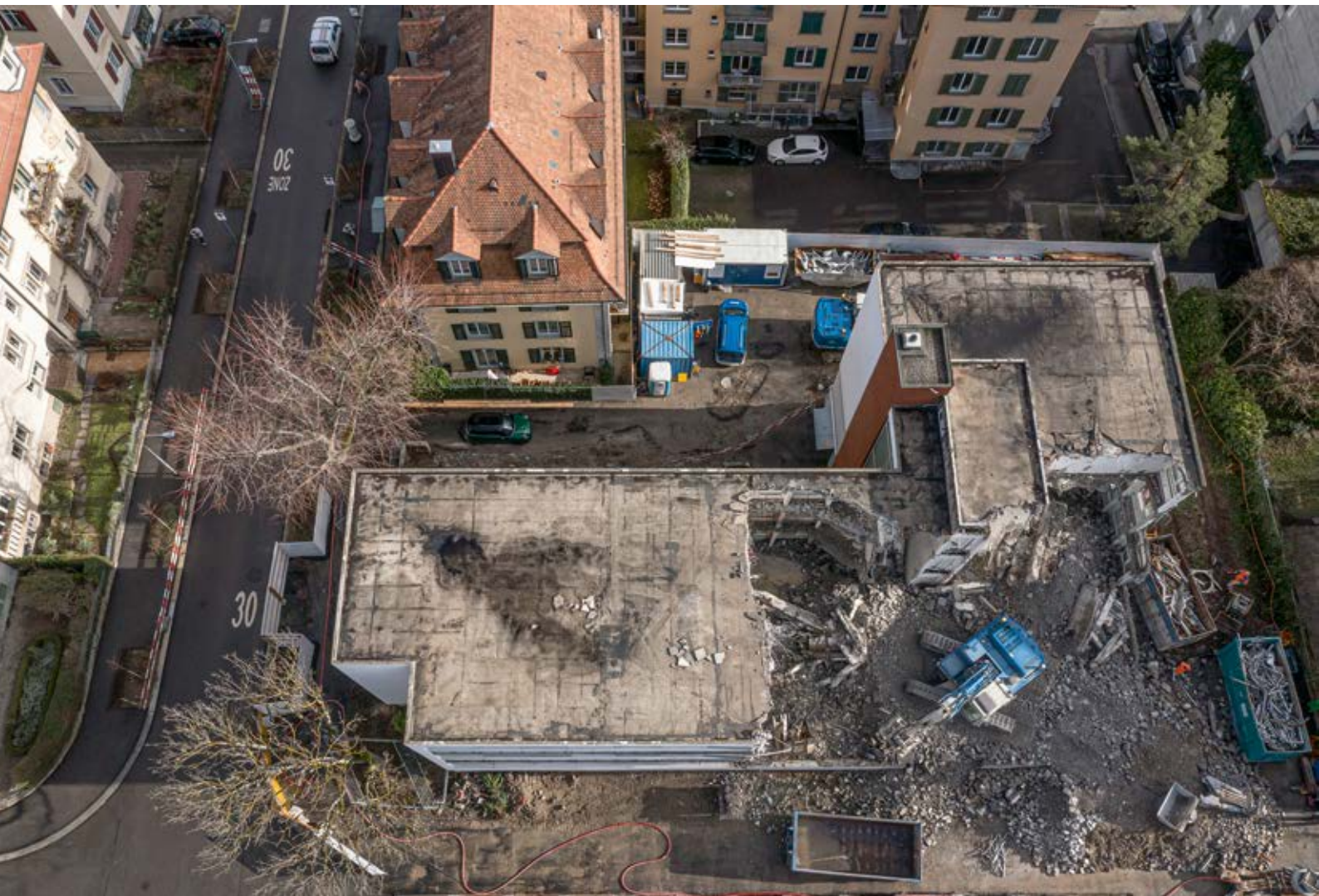
DAS RÜCKZUBAUENDE GEBÄUDE MIT ANSCHLIESSENDER BAUGRUBE UND ERDWÄRMESONDENBOHRUNG DURCH KIBAG GEOTHERM.
