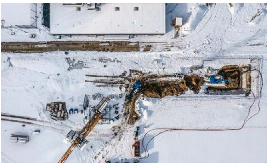
AUSHUBARBEITEN MIT BÖSCHUNGSSICHERUNG.
