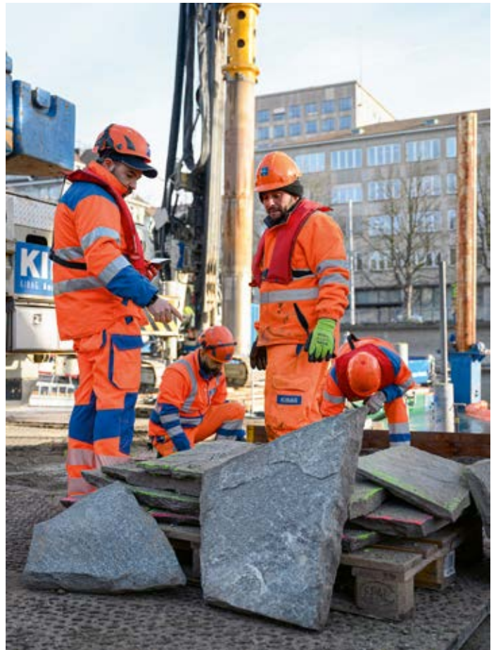
DIE NATURSTEINPLATTEN WERDEN ZURÜCKGELEGT.
