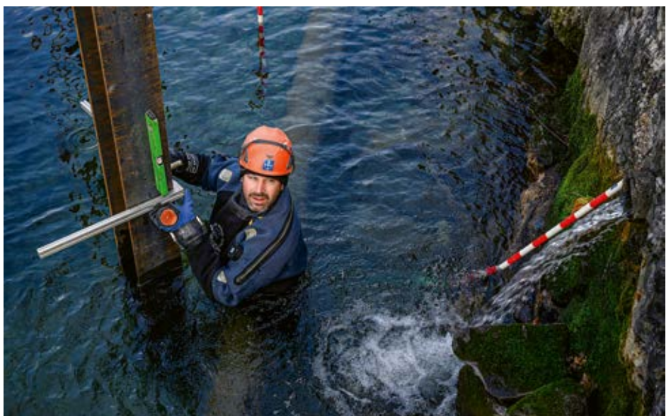
BAUFACHARBEITER BENI GISLER BEI DEN UNTERWASSERARBEITEN.
