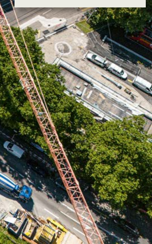
BAUSTELLE BEIM ZÜRCHER HAUPTBAHNHOF.
