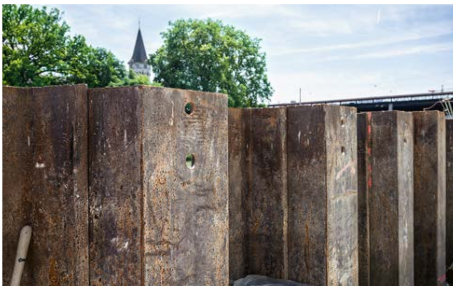
SPUNDWÄNDE DES KIBAG W+S.
