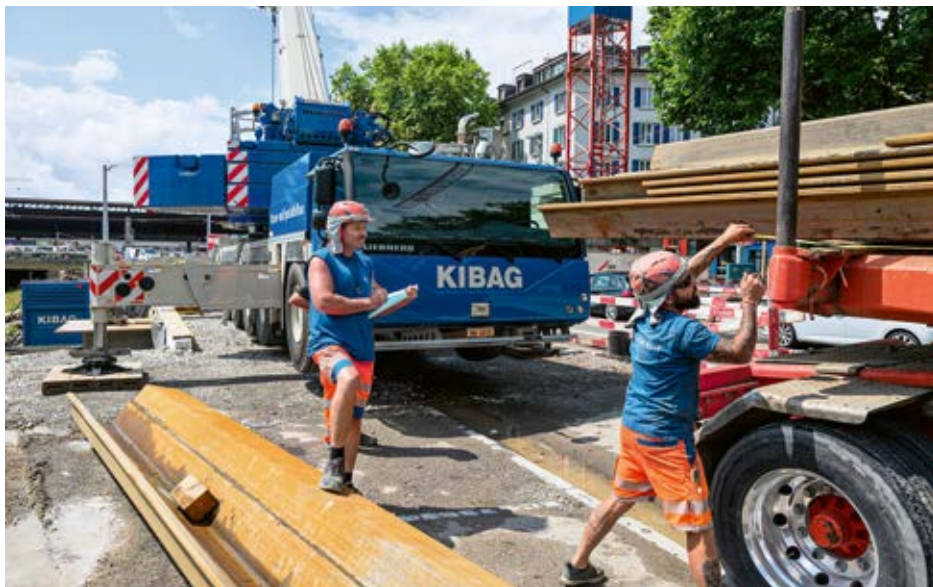
ANLIEFERUNG DER BAUGRUBENAUSSTEIFUNGEN UND SPUNDWÄNDE.
