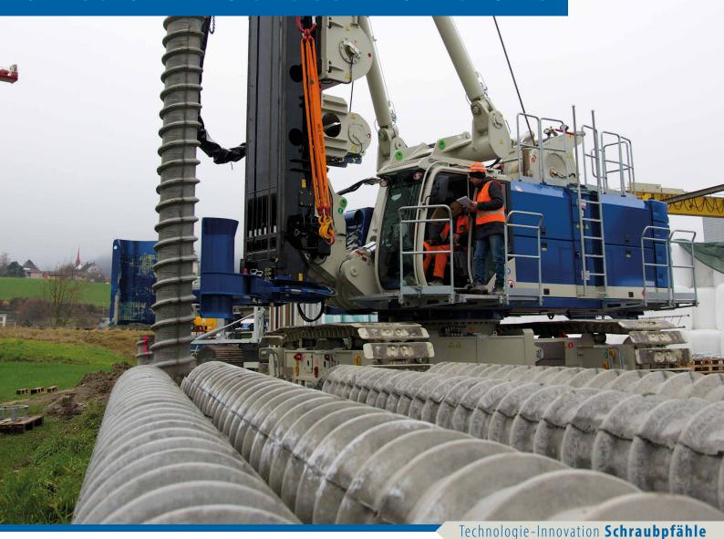
Verdichtetes Bauen erfordert neue Lösungsansätze hinsichtlich Lärmemissionen, Erschütterungen und Einbautechniken. Schraubpfähle von KIBAG arbeiten leise, erschütterungsfrei und hochpräzise bis 40 Meter in die Tiefe.
