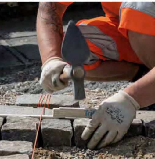
Je nach Ihren Anforderungen und den verwendeten Materialien unterscheidet sich die Bauweise: Bei der ungebundenen Bauweise werden die Pflastersteine in ein Sandsplittgemisch versetzt und mit Sand ausgefugt.
