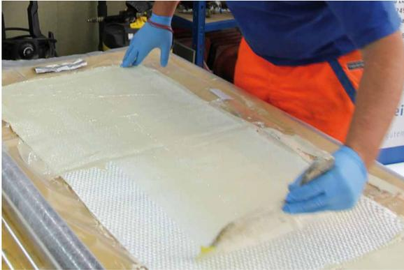
**Eine wirtschaftliche und zuverlässige Alternative.** Kurzliner-Schläuche sind bei örtlich abgegrenzten Schäden eine wirtschaftliche Alternative zu klassischen Reparaturverfahren. Vorrangiges Ziel ist hierbei die Wiederherstellung der Dichtigkeit des Kanals. Das Altrohr wird dabei in einem begrenzten Bereich mit einer Innenbeschichtung versehen. Abhängig vom gewünschten Ergebnis werden dafür die Materialien ausgewählt.
