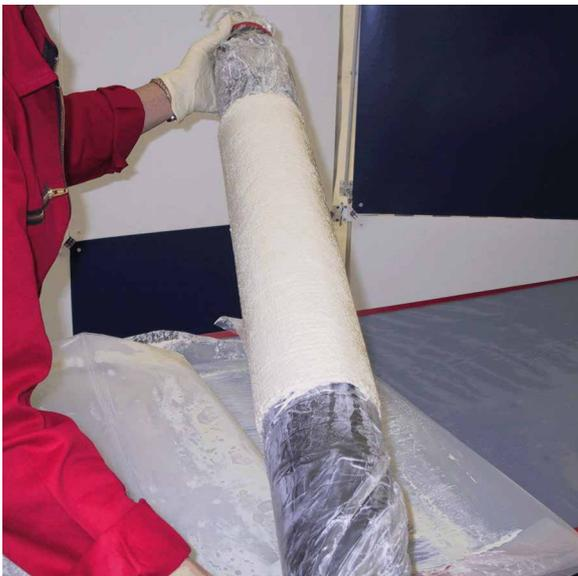
**Dichte Lösung durch grossflächige Verklebung.** Unter ständiger Kamerabeobachtung bereitet unser Roboter fachmännisch den Haftgrund vor. Ob Bürsten, Strahlen, Schleifen oder Fräsen – eine exakte Arbeitsweise ist entscheidend bei dieser Technik. Anschliessend werden die vor Ort konfektionierten und mit Harz getränkten GfK-Matten mittels Spezialpacker positioniert und mit steuerbarem Druck an die Wandung des defekten Rohres gepresst.
