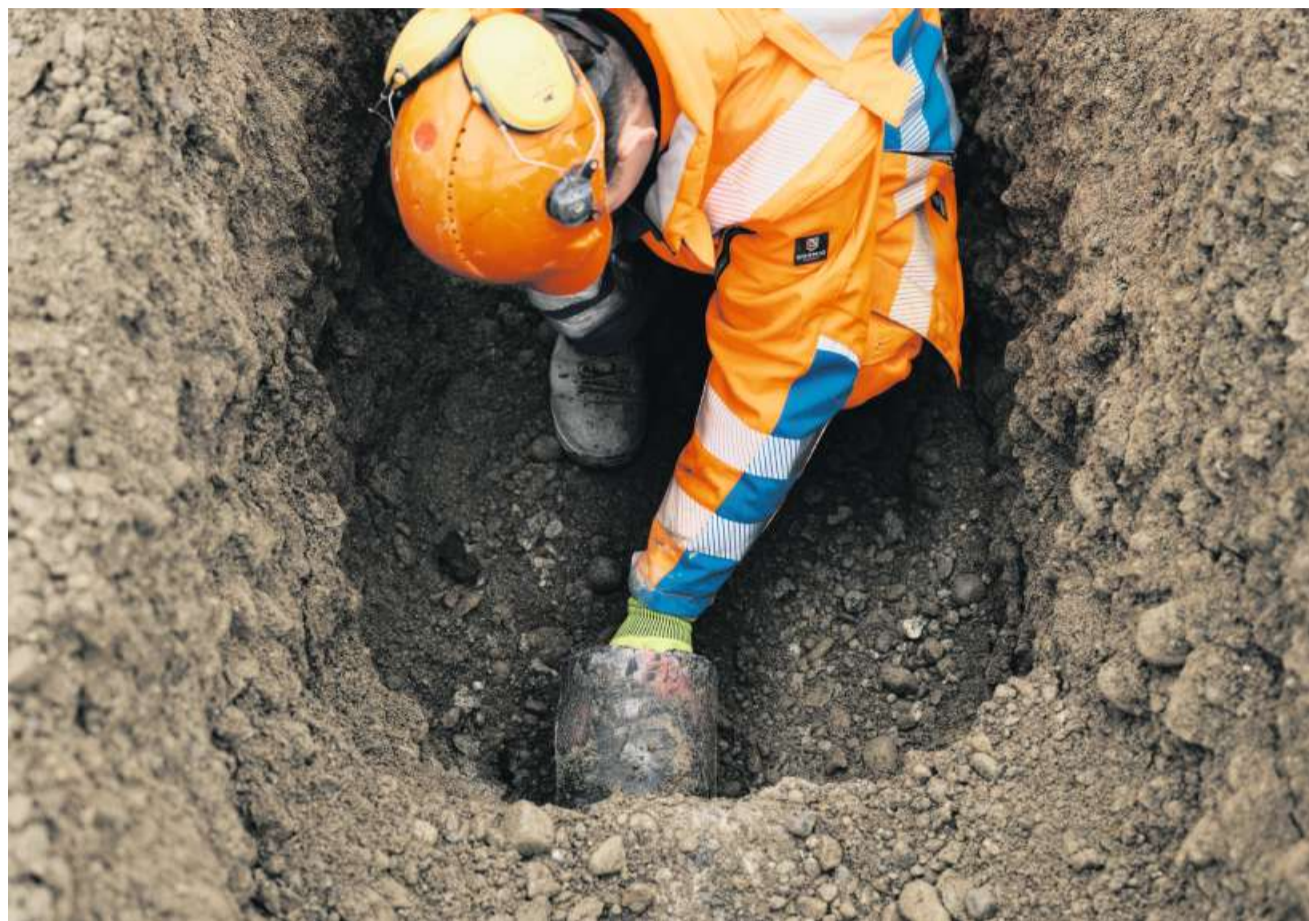
Hier müssen die Lehrlinge ein neues Rohr anschliessen: Blick in einen Graben in der Wallisellenstrasse in Oerlikon.
