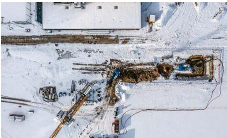
chen ist einen Materialersatz nötig, da einige Bauteile höher liegen. Aufgrund des hohen Grundwasserspiegels, welcher nur mittels offener Wasserhaltung abgesenkt wurde, waren unsere Arbeiten zudem erschwert.
