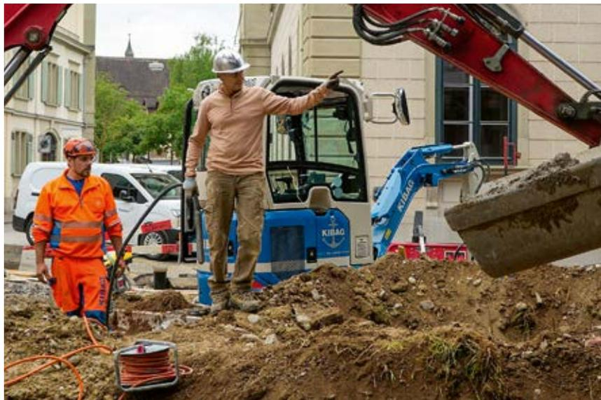
SCHALUNG AUS LOKALEM AUSHUB WIRD MIT KIBECO CLEANCRETE OULESSE AUSGEGOSSEN.
