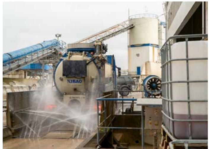
JEDER LKW, DER KONTAMINIERTEN AUSHUB ABLÄDT, WIRD ABGESPRITZT, BEVOR ER DAS AREAL VERLÄSST.
