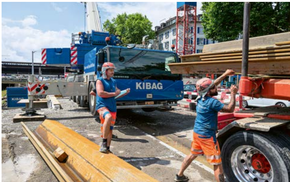
ANLIEFERUNG DER BAUGRUBENAUSSTEIFUNGEN UND SPUNDWÄNDE.
