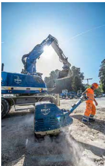
EINBAU DER FUNDATIONSSCHICHT.
