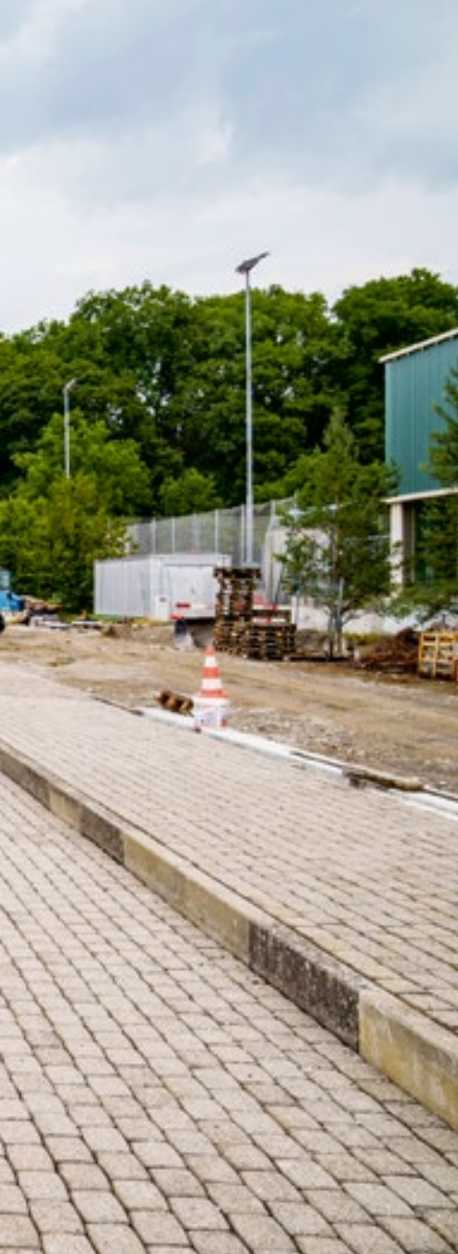
WÄHREND AUF DER BAHN TRAINIERT WIRD, WIRD DANEBEN GEPFLÄSTERT.
