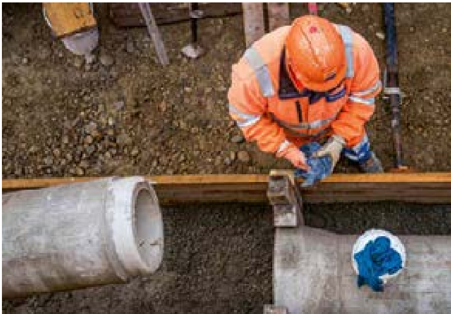
ROHRVERLEGearbeiten IM GESPRIESSTEN GRABEN.
