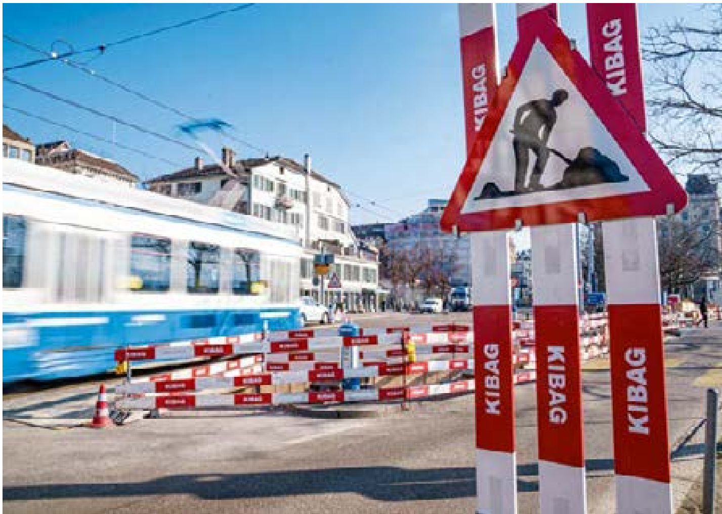
AUCH AM ZÜRCHER LIMMATQUAI WERDEN LEITUNGEN VERLEGT.
