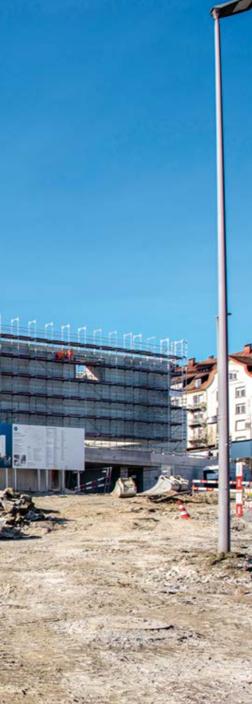
VERBREITERUNG SPLÜGENSTRASSE VOR DER NEUEN OLMA-HALLE.
