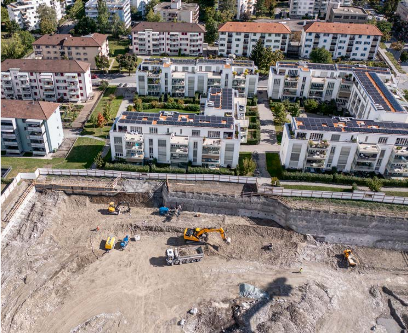
DIE DIMENSION DER BAUGRUBE IST GEWALTIG.
